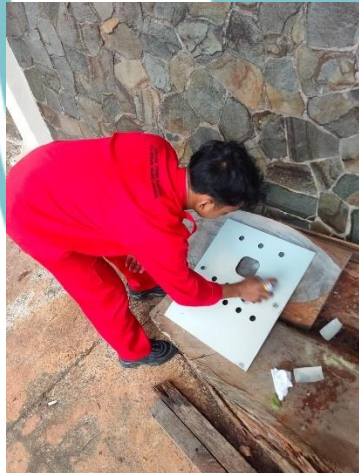
Lampiran 11 Mempilox panel dengan warna baru
