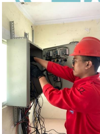
Pemasangan Clamp Pada Busbar Base-Plate Panel Modul
