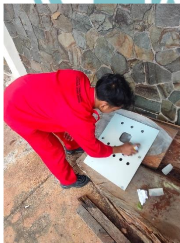
Mempilox panel dengan warna baru
