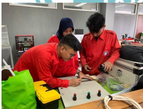
Pemetaan layout alat di pintu panel
