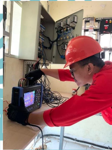
Pemasangan Clamp Pada Alat PQA
