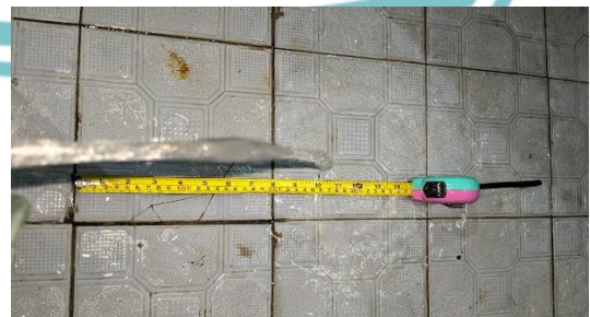
Pengukuran jarak tembok pompa air
