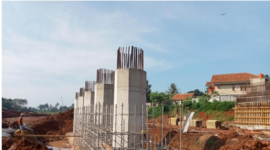
Gambar 4. 26 Hasil Pekerjaan Kolom (Sumber : Dokumen Perusahaan)
