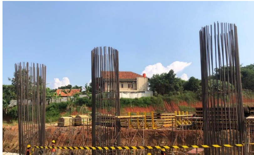
Gambar 4. 20 Baja Tulangan (Sumber : Dokumen Perusahaan)
