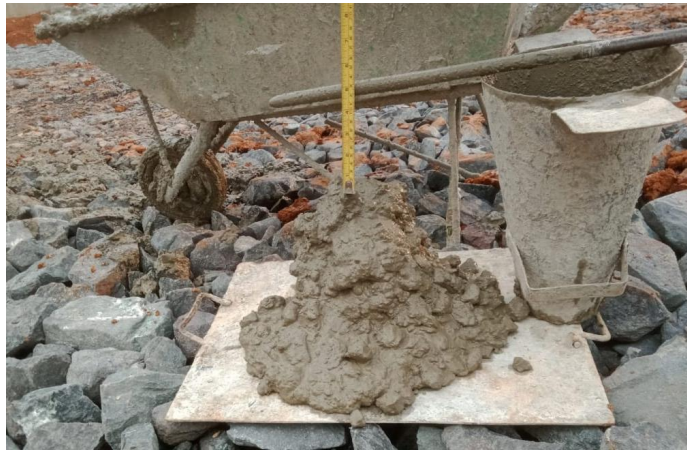
Gambar 4. 19 Uji Slump Kolom (Sumber : Dokumentasi Pribadi)
