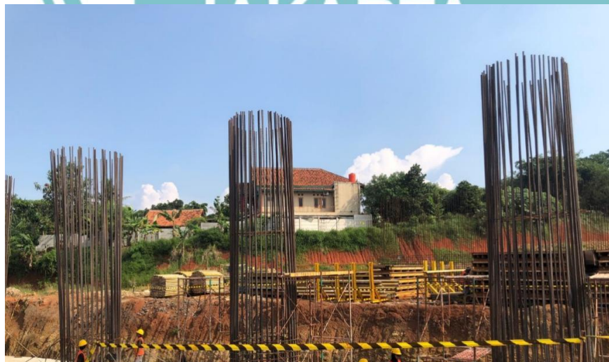
Gambar 4. 25 Pembesian Kolom (Sumber : Dokumen Perusahaan)
