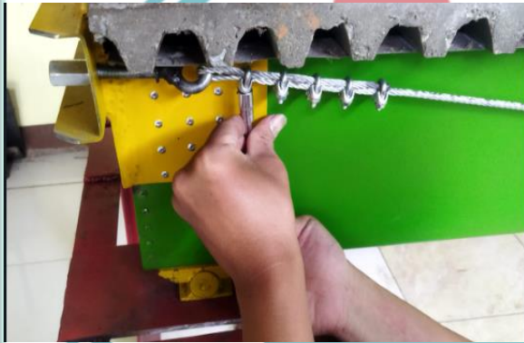
Pemasangan Sling Pada Angkur
