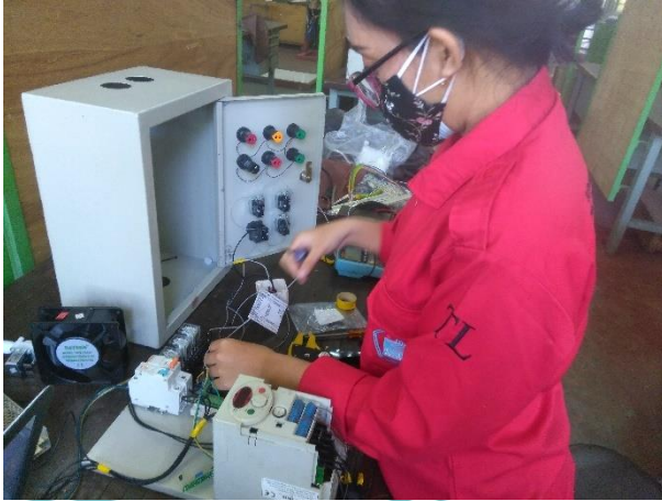
Wiring pada Komponen Panel
