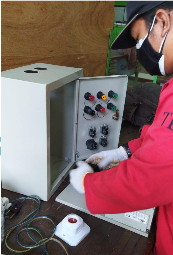
Pemasangan Komponen ke Panel
