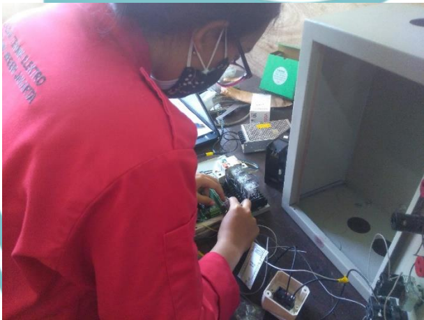
Pemasangan Komponen ke Panel
