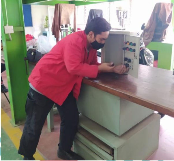
Pemasangan Komponen ke Pintu Panel
