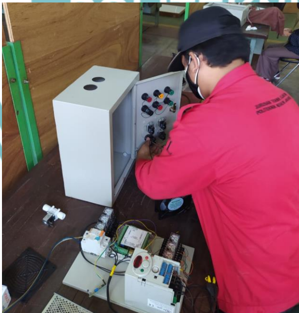
Wiring Komponen pada Pintu Panel
