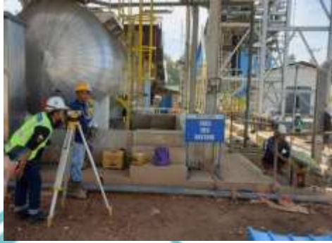
Inpeksi Leveling & Centerline
