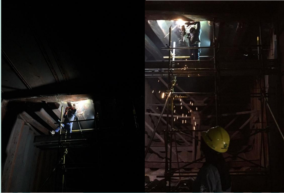
Gambar 7 Corrective Maintenance - Pengelasan EJ Inlet HRSG
