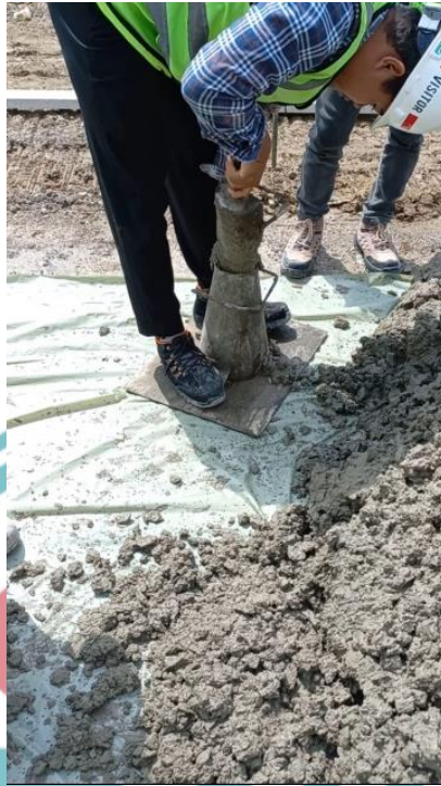
Gambar 4. 39 Pengambilan Test Slump
