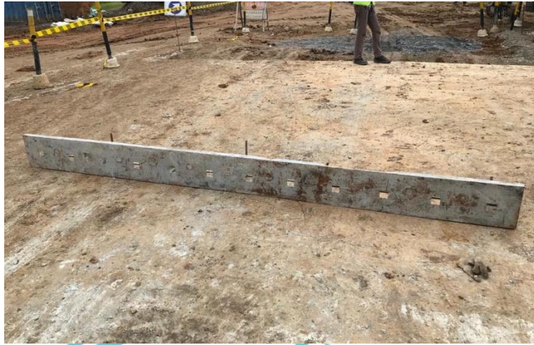
Gambar 4. 29 Bekisting Start Cor dan Stop Cor
