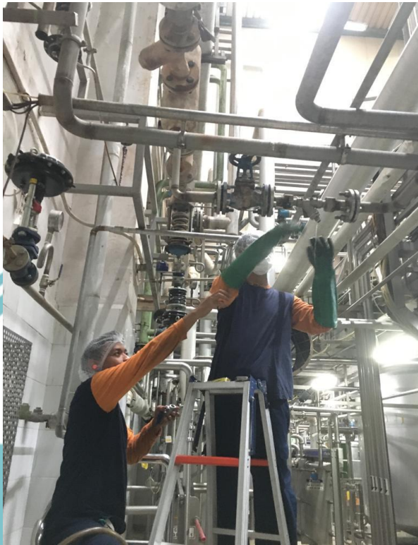
Membantu Mekanik Utility Mengganti Ball Valve
