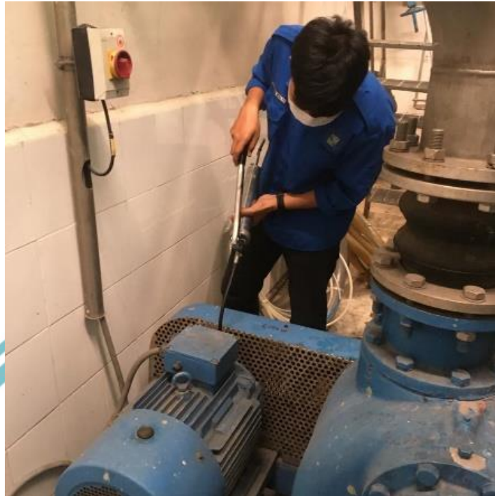
Memberikan Grease pada Motor Pump
