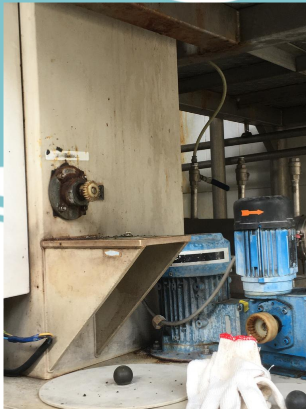
Mengganti Bearing Polimer Pump di Area WWTP
