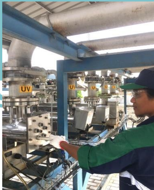
Dokumentasi Proses General Cleaning Pada Ultraviolet Untuk Pembaruan COP
