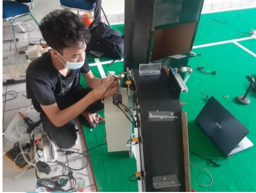
Gambar L-3 Instalasi Pemasangan Sensor Infrared
