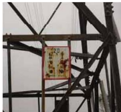
Gambar 2. 9 Rambu Identifikasi Tower (Joko, Buwono, & Zamrudi, 2010)
