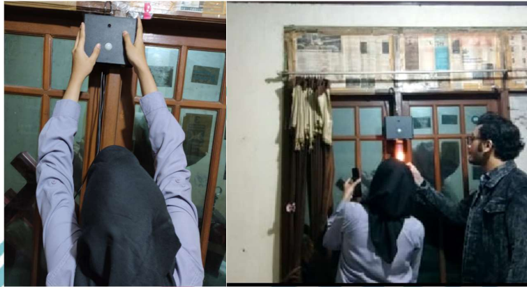
Foto Pemasangan & Pengujian Alat di Gudang Ternakpedia
