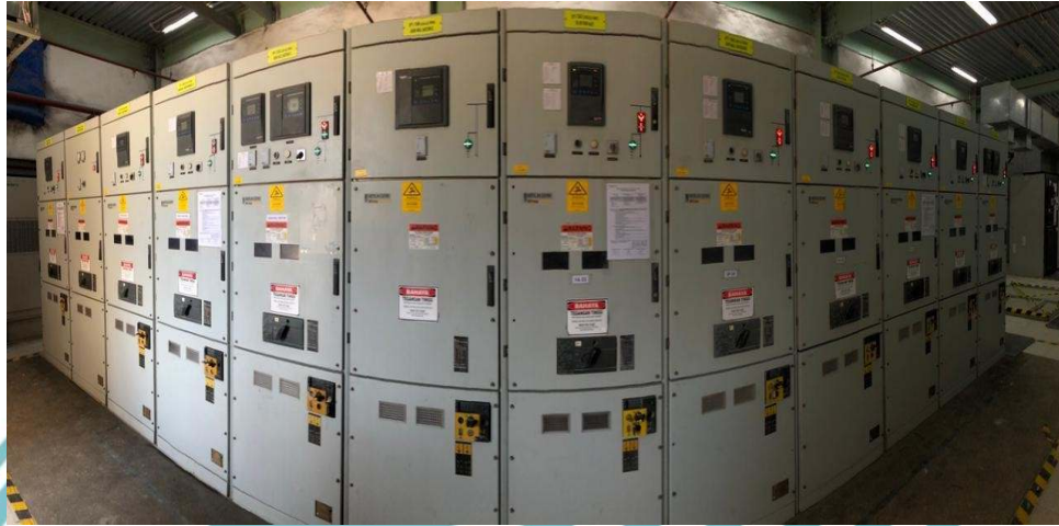
Gambar 1. 1 Switchgear
