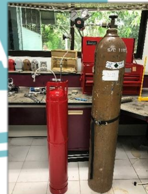
Purging menggunakan gas helium.
