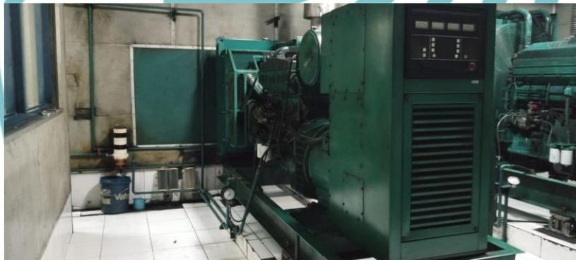
Gambar 2. 7 Mesin Diesel 4 Tak
