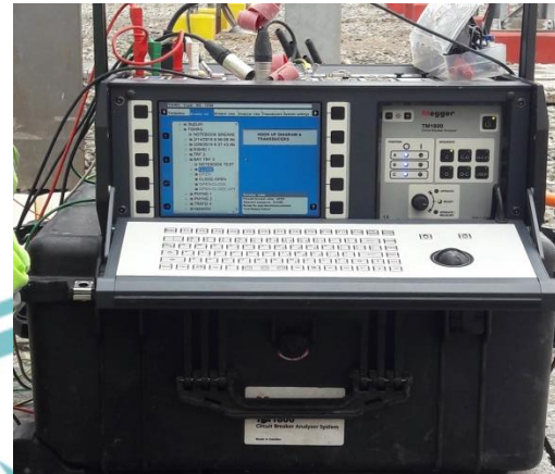
Alat Pengujian Keserempakan PMT 150 KV
