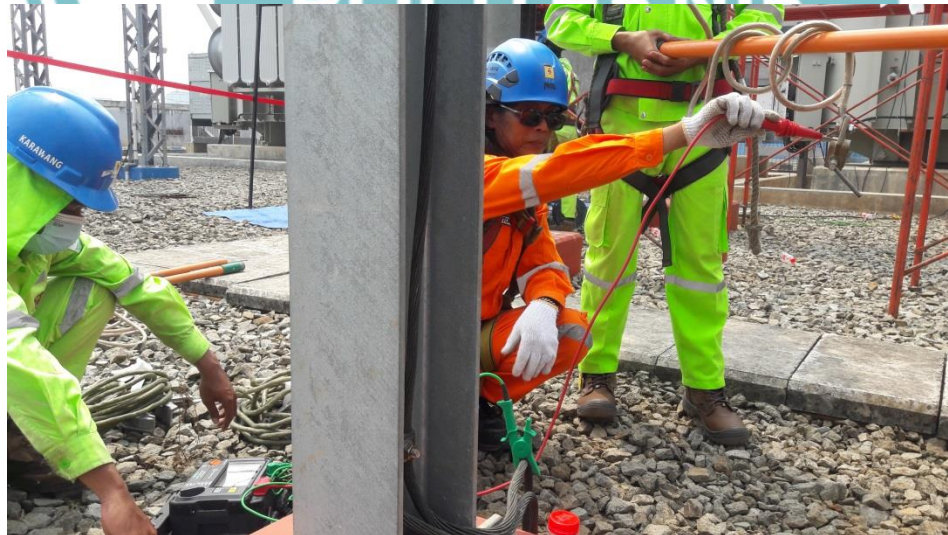
Pek. Pengujian Tahanan Isolasi PMT 150 KV
