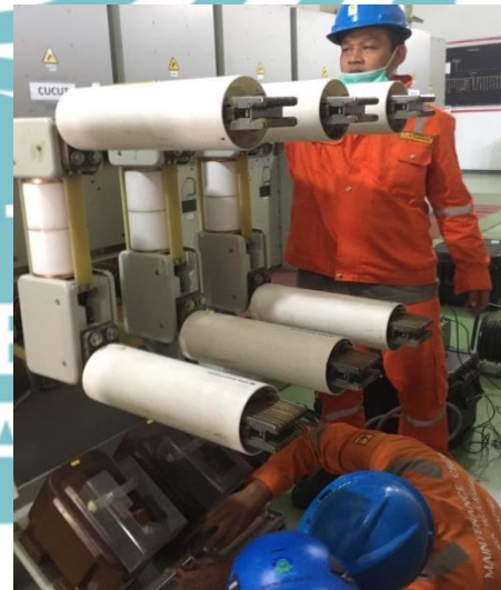
Pemeliharaan PMT 20 KV
