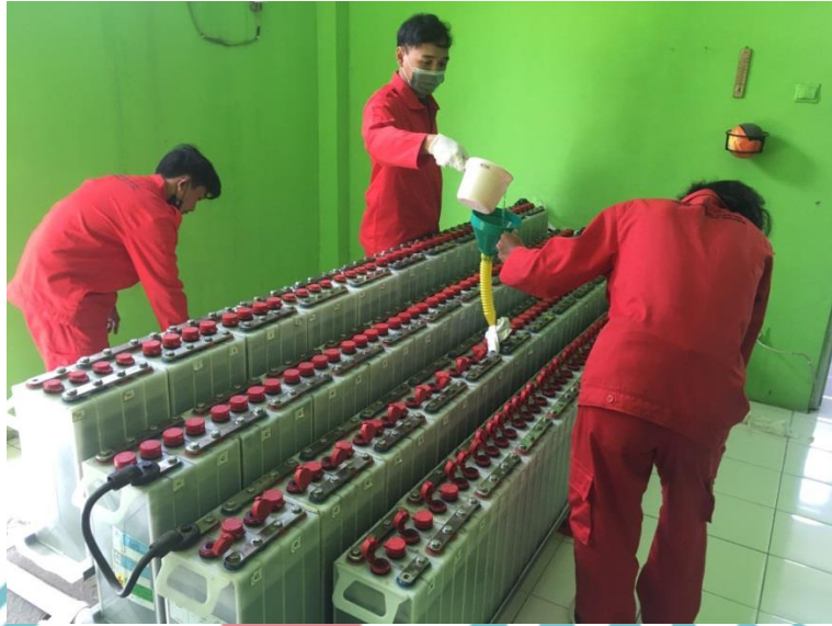
Pengisian Air Battery Pada GI Jui Shin
