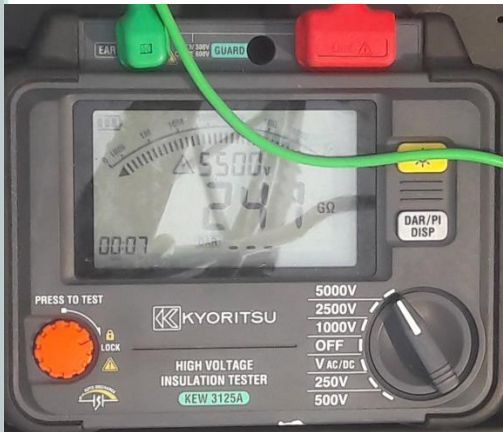
Alat Pengujian Tahanan Isolasi PMT 150 KV
