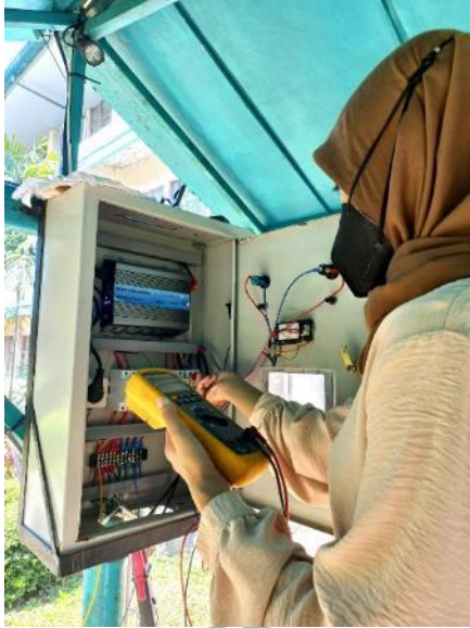
Proses pengambilan data ukur menggunakan multimeter
