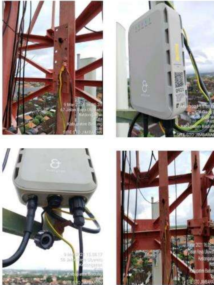
Grounding pada Tower
