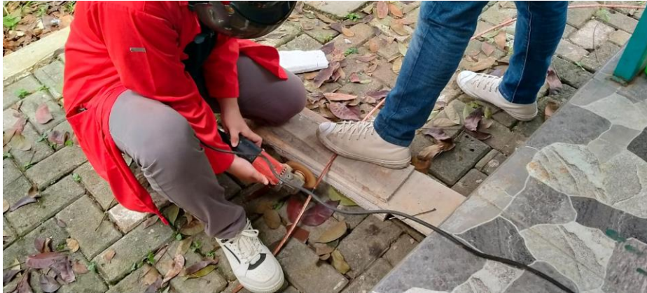
Lampiran 1. Proses pemotongan kawat BC
