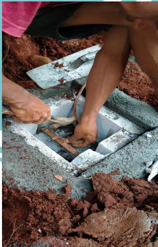
Lampiran 8. Proses Pembuatan Bak Kontrol
