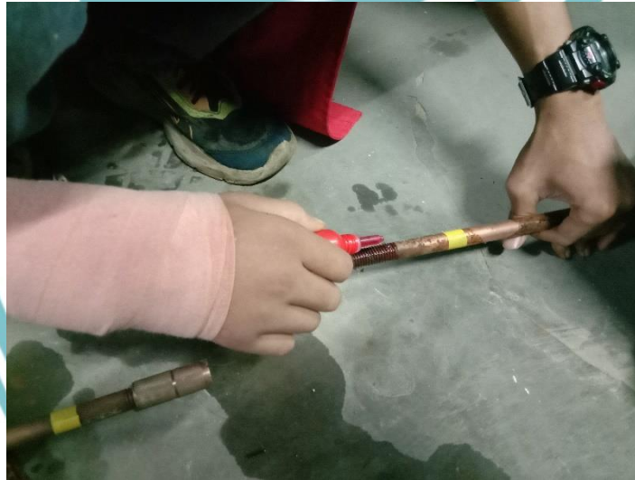
Gambar L. 4 Proses Penyambungan Batang Rod
