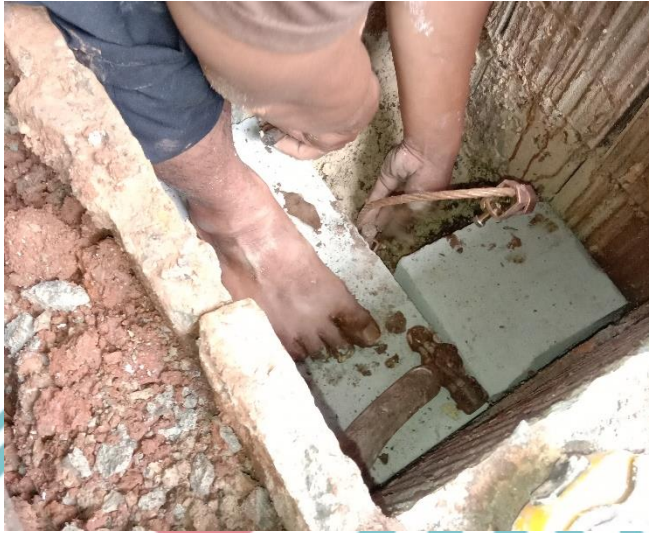
Gambar L. 5 Proses Pembuatan Bak Kontrol
