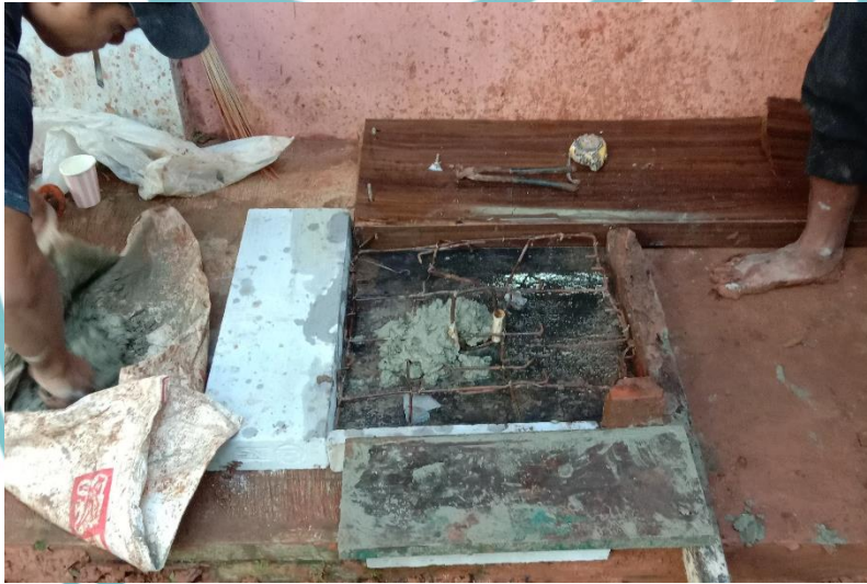
Gambar L. 6 Proses Pembuatan Tutup Bak Kontrol
