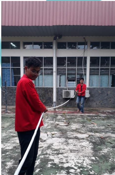
Penarikan kabel dari tiang PLTS ke panel desk di dalam bengkel semester 4
