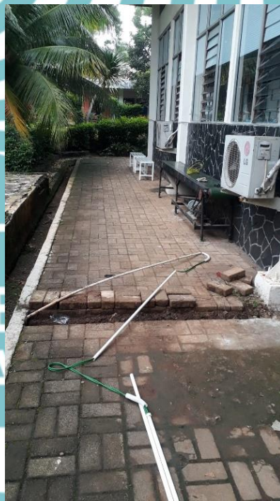
Penarikan kabel dari tiang PLTS ke panel desk di dalam bengkel semester 4
