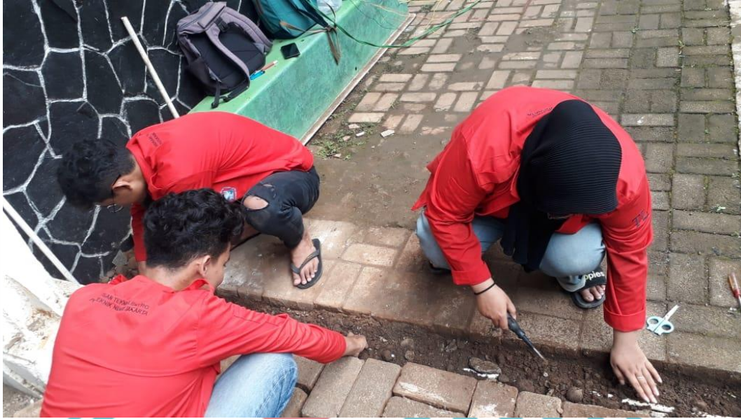
Proses pembongkaran jalur pipa kabel
