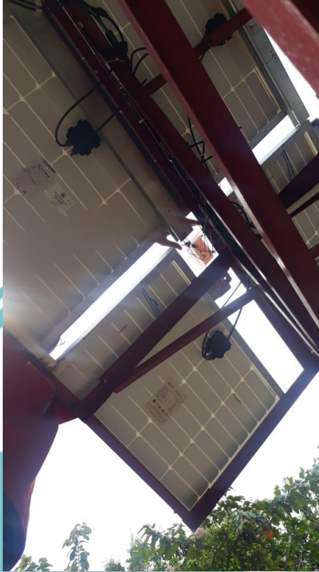
Pemasangan sensor Suhu dan Intensitas
