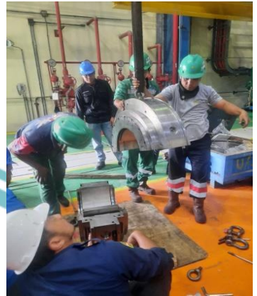
Pembongkaran bearing
