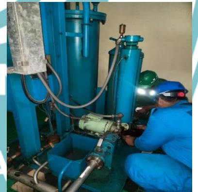
Pembersihan oil yang bocor pada GVR
