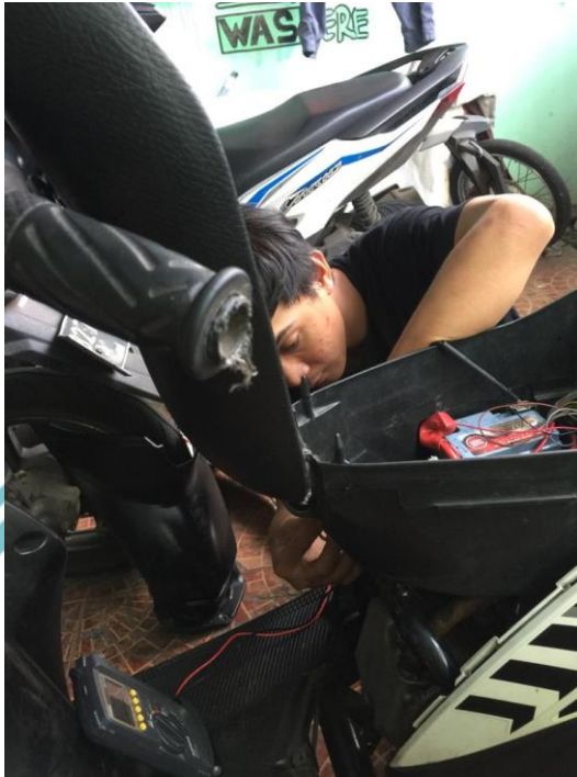
Pengecekan Tegangan pada Kabel dari Input Motor
