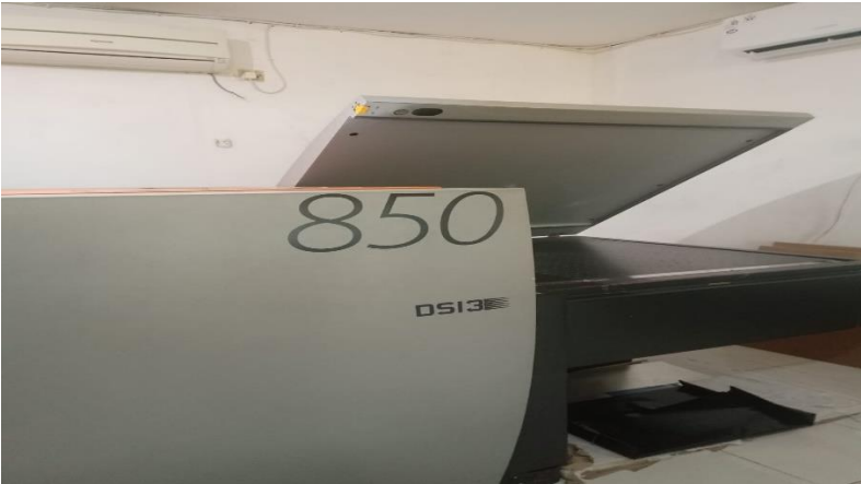
Foto Ruang Tempat Mesin imaging
