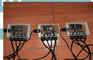
Gambar L.5 Tampak Dalam 3 Box Sensor Proximity Infrared
