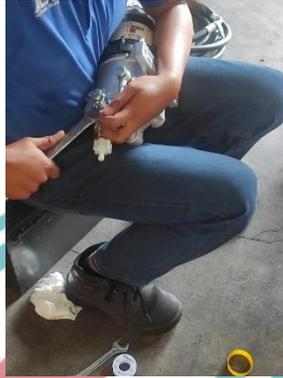
Gambar 3.12 Pemasangan Konektor Kelubang
