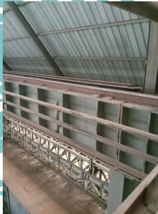
*Conductor Bar* sebagai sumber penghantar listrik tiga fasa untuk *overhead crane*
