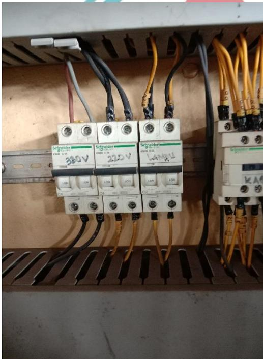
MCB Sebelum dan Sesudah Trafo serta Lampu Kabin (Tidak ada dalam wiring diagram)
