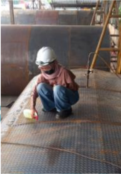
Foto Kegiatan Tes Penetrant pada Water Tank
