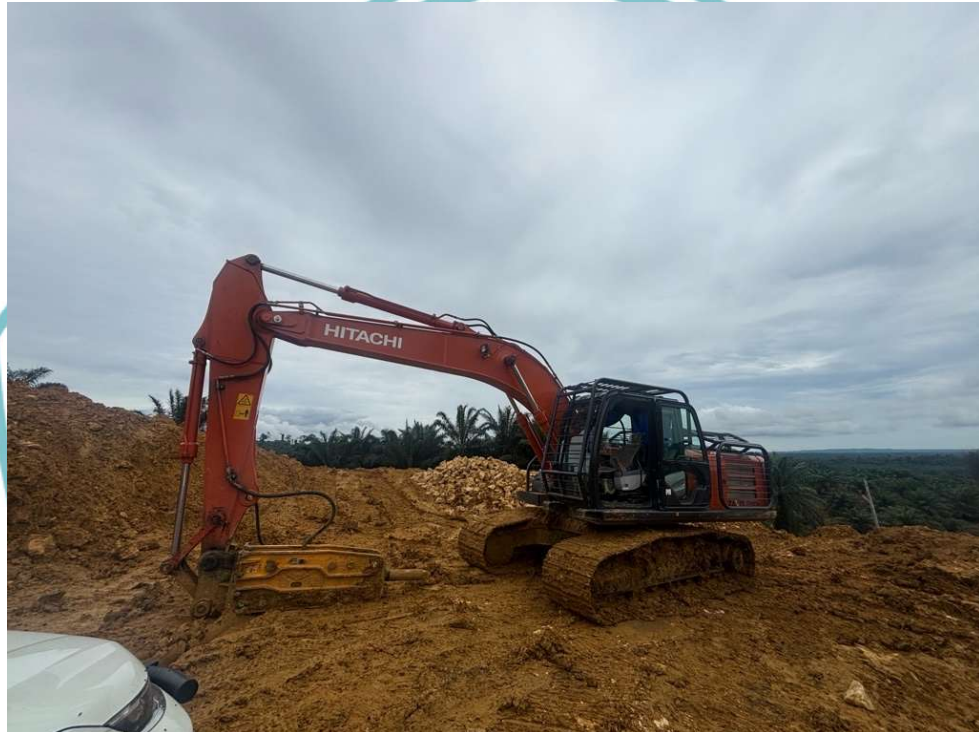
Gambar 4.1 Excavator dengan attachment hydraulic breaker
