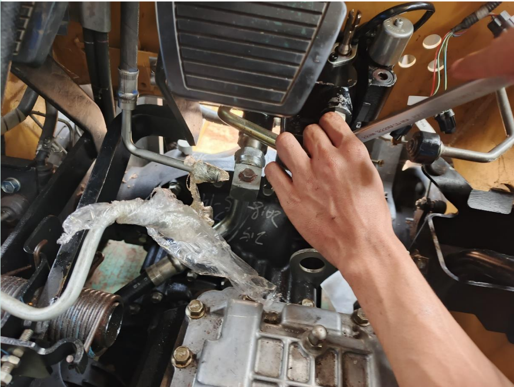
Lampiran 4. Pemasangan Control Valve
