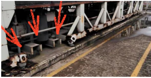
Gambar 1. 2 Titik Korosi Rangka Eksting
