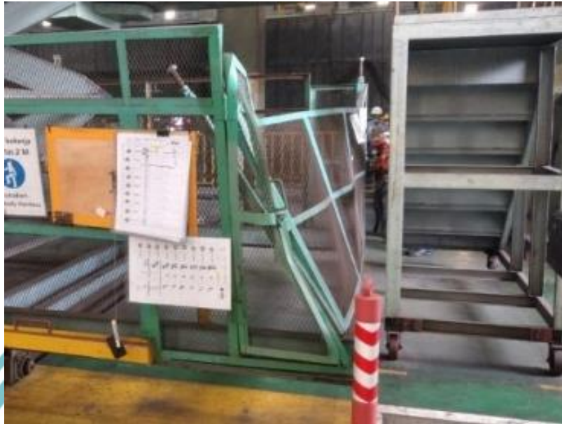
Gambar 1.1 Insiden forklift menabrak pagar mesin rotator welding Sumber: Dokumentasi penulis, 2026
