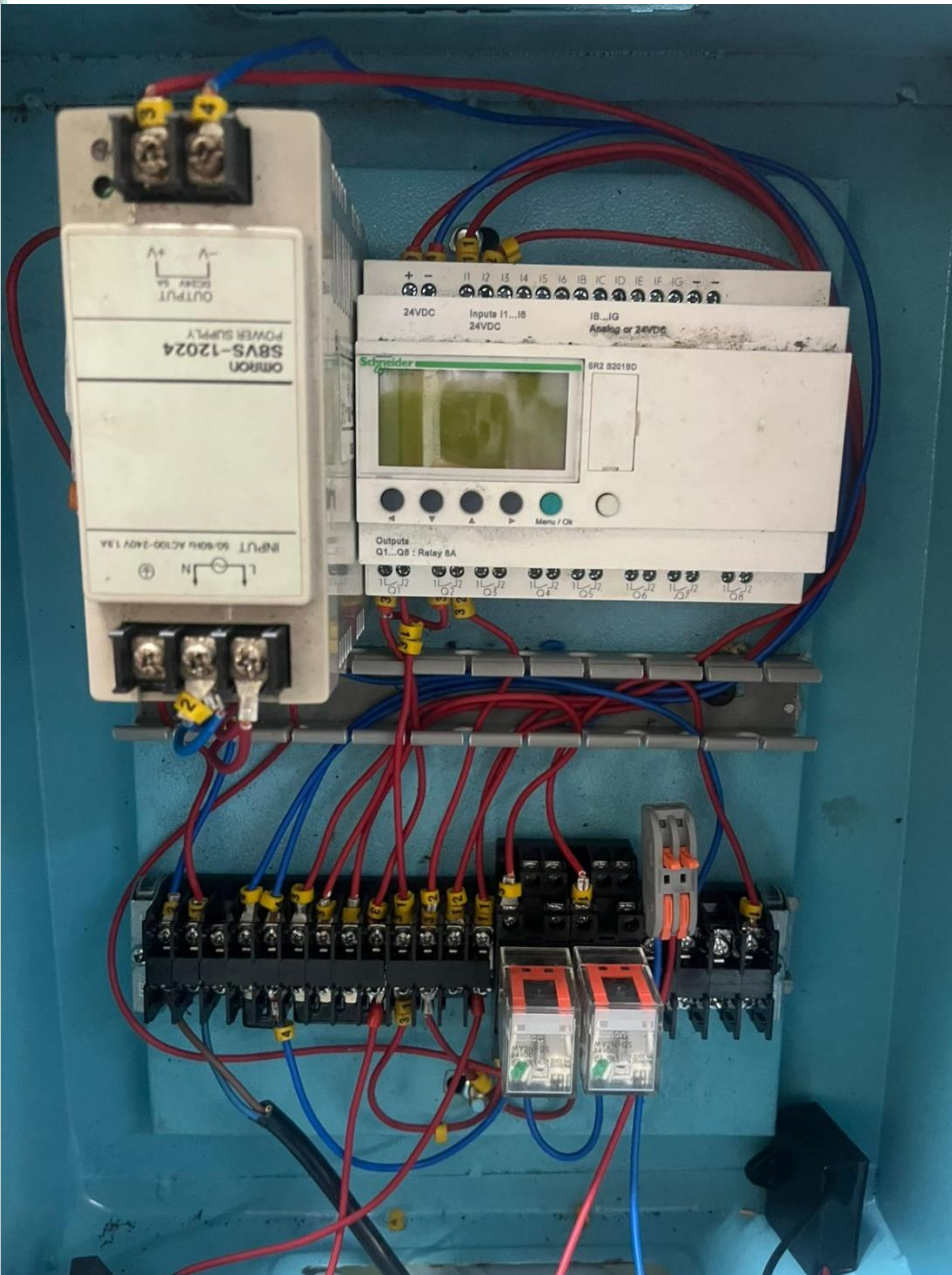
Lampiran 14. Dokumentasi Proses Perakitan Sistem Wiring Panel
