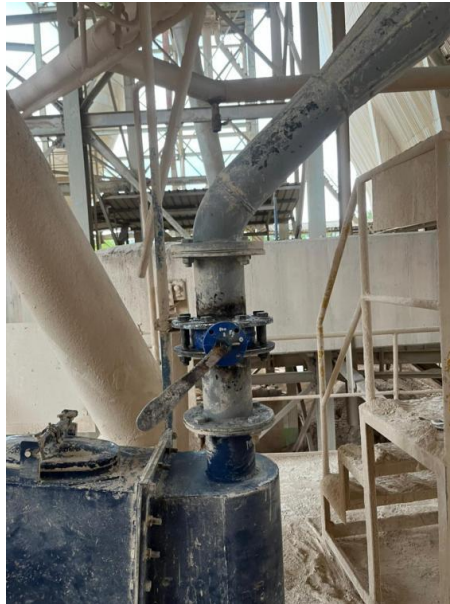
Gambar 5. Hasil pemasangan butterfly valve pada pipa Venting Hood pada posisi sebelum elbow
