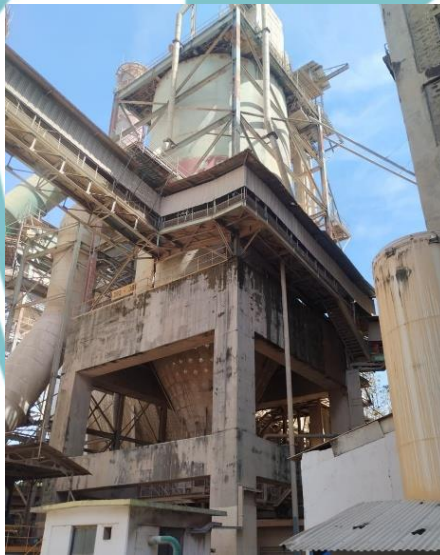
Gambar 1.2 Gedung Dust Bin Sumber : Dokumentasi Pribadi
