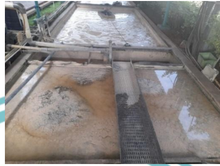
Gambar 1.3 Overflow kolam endapan 2 di PT X Sumber: Dokumen pribadi
