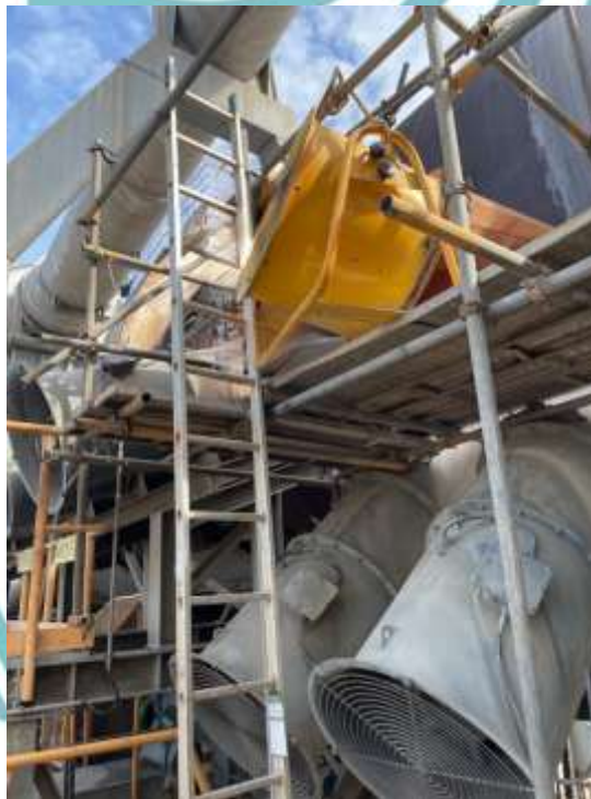
Gambar 1. 2 Penambahan scaffolding untuk cooling shell kiln tambahan
