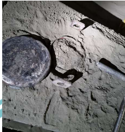
Gambar 1.1 Plug up pada air slide
