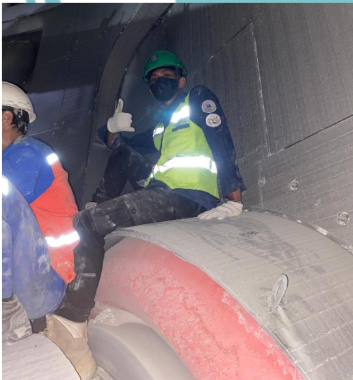
Lampiran 2 Kegiatan inspeksi pada mesin vertical roller mill
