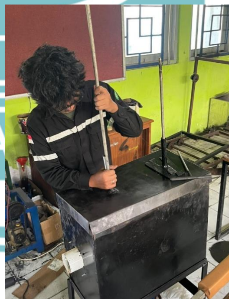
Lampiran 1.4 Proses Pemasangan Pipa Angin
