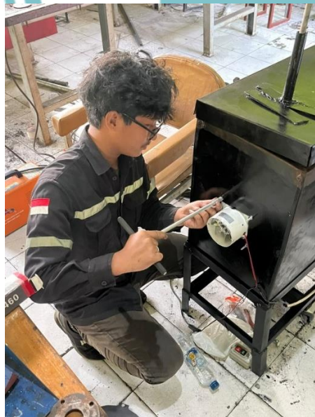
Lampiran 1.3 Proses Pemasangan Exhaust Fan
