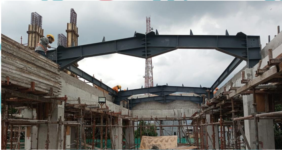
Gambar 2. 4 Rafter pada proyek
