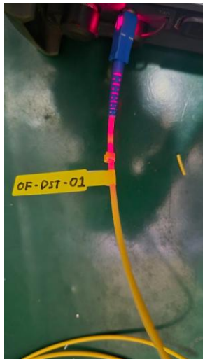
Pemasangan VFL pada titik awal jalur distribusi OF-DST-01.
