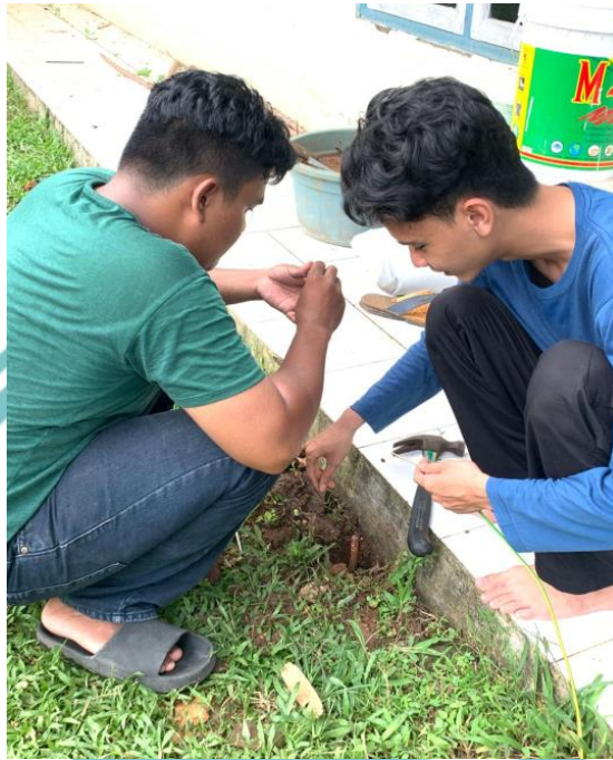
Lampiran 3. Dokumentasi Pemasangan Grounding
