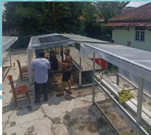
Lampiran 2. Dokumentasi Proses Pemasangan Panel PV
