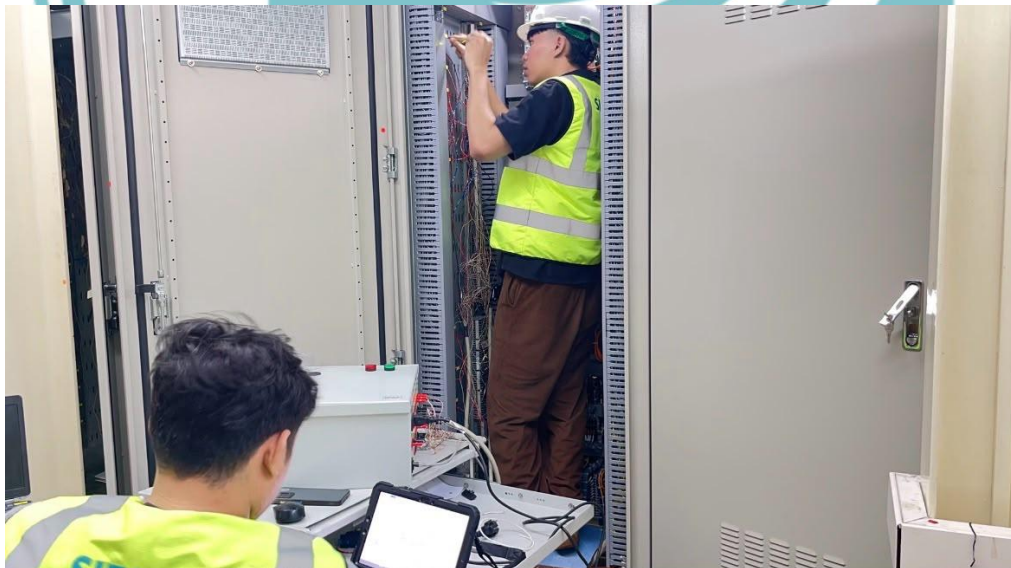
Lampiran 2. Pemasangan simulator ke panel
