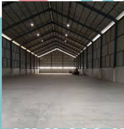
Jalan Dewi Sartika No. 25 Jakarta Selatan
