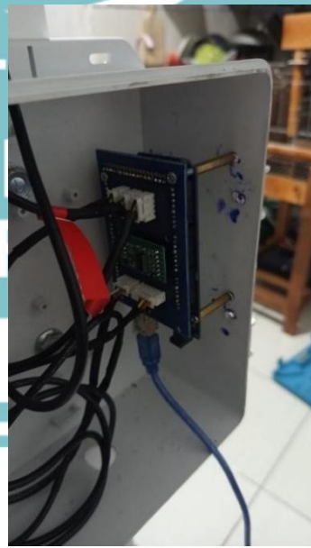
L-3. 4 Foto Wiring PCB
