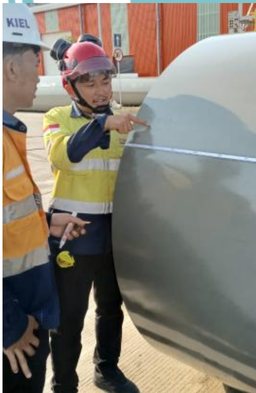
Pengukuran Sebelum Installing Ducting
