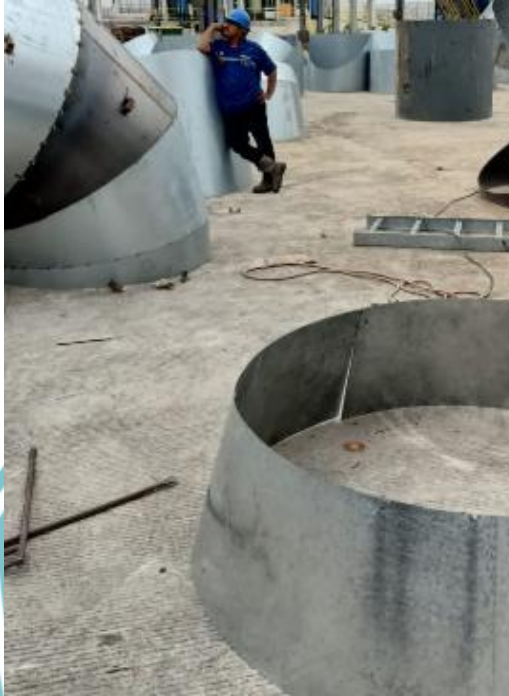
Lingkup Kerja Pengelasan Ducting
