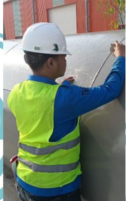
Inspeksi Welding Dengan Welding Gauge
