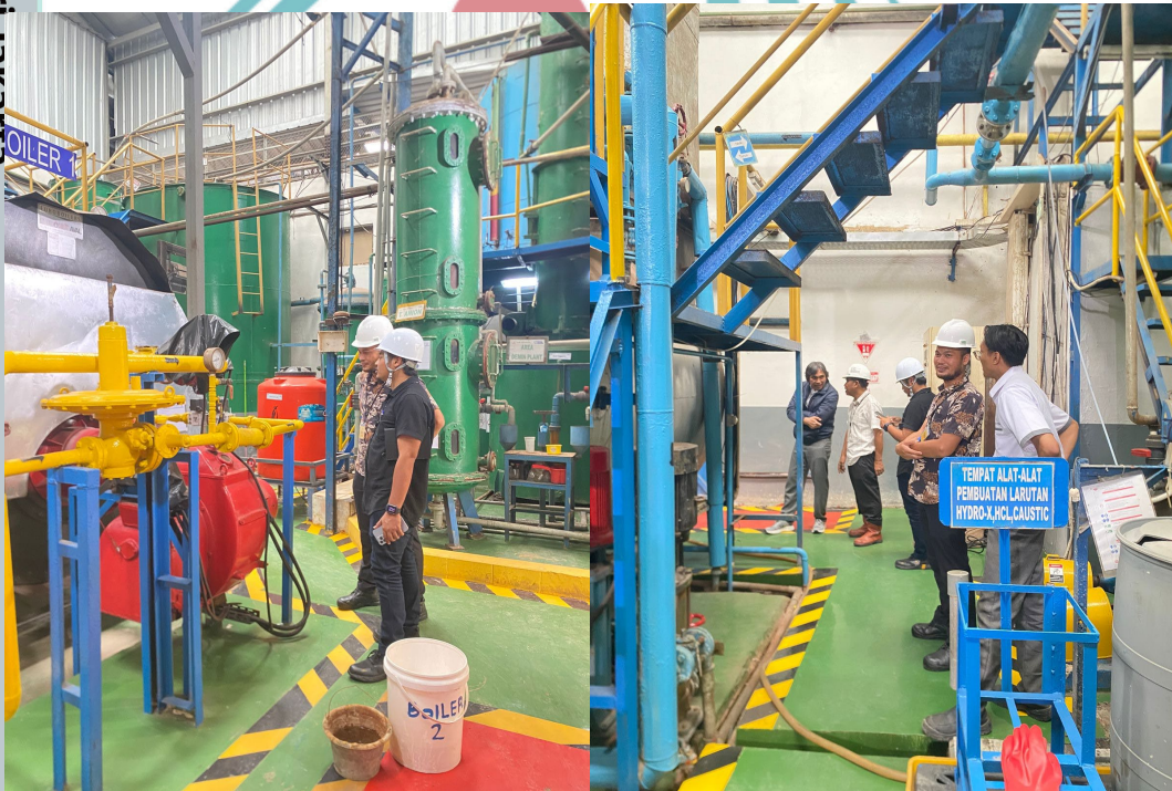
Gambar 3.1 Dokumentasi Inspeksi Jalur Pipa
