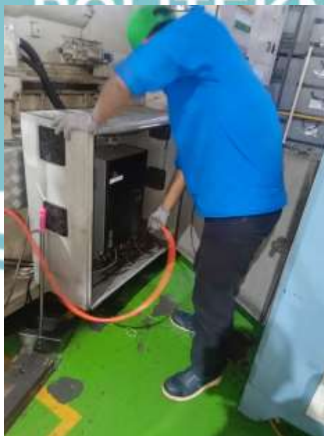
Proses Preventive Maintenance pada bagian kelistrik (Panel Inverter)
