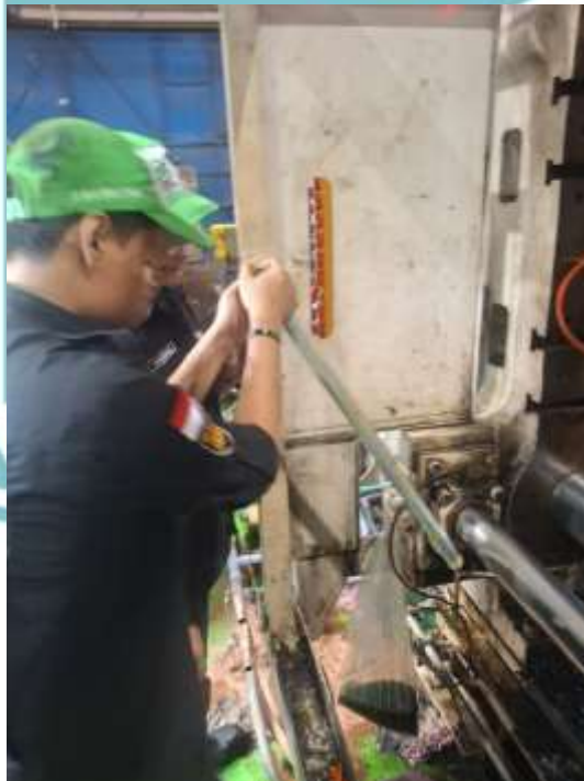
Proses bongkar cylinder moving platen terindikasi kebocoran pada mesin Toshiba 650 TON,
